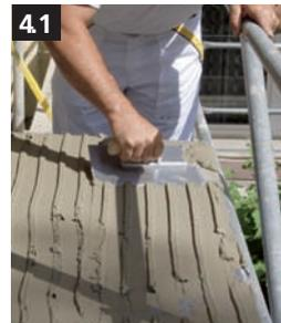
**4.1** Die neue Dämmplatte (Polystyrol oder Mineralwolle) wird meist vollflächig mit Fugenversatz verklebt.
